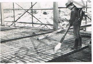
Moniereisen (Bild oben) genauso wie die gefrorene Schicht von Kieshaufen (Bild unten) werden mit dem "Supra"-Flammgerät vom
