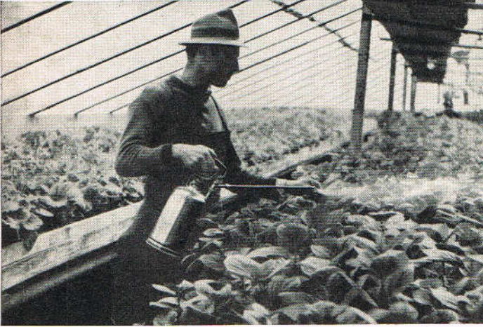
Die selbsttätige Handspritze „Ideal“ – eine beliebte Helferin der Gärtner im Gewächshaus. Die bewegliche Düse gibt dem Spritzstrahl jede gewünschte Richtung.
